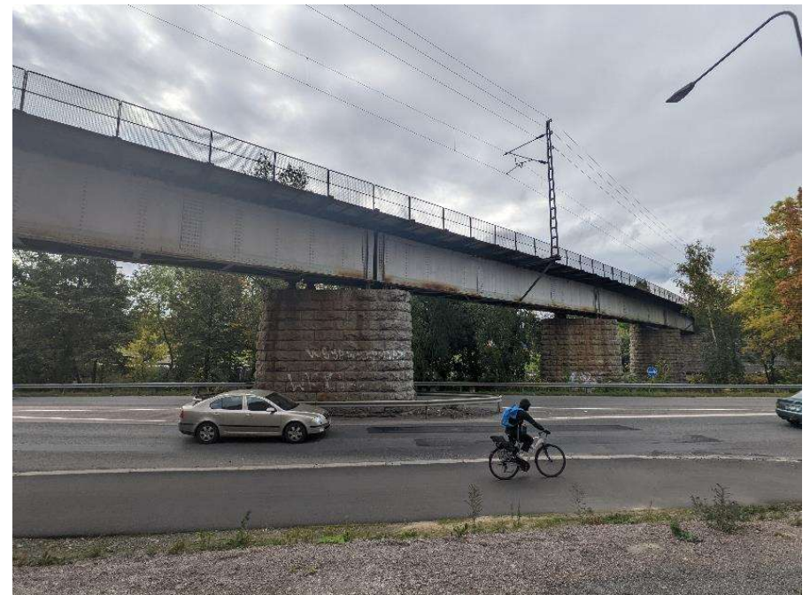
Tampereen valtatie alikulkusilta
